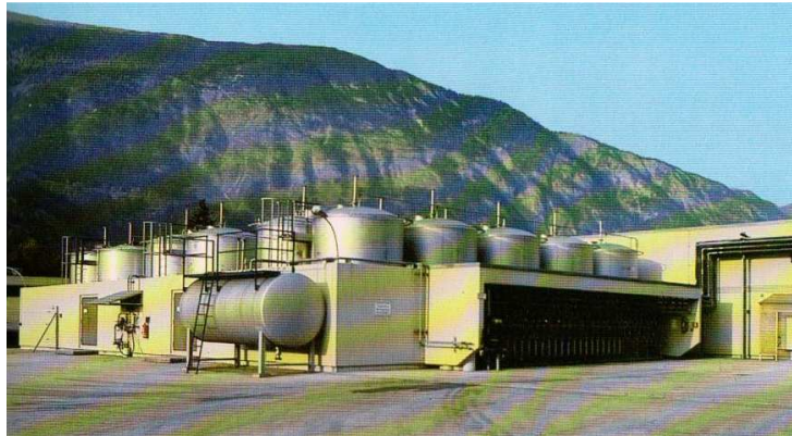
Lösemittel-Lager das den höchsten Sicherheitsvorschriften entspricht – die oberirdischen 30 Tanks nehmen je 35.000 Liter Flüssig-Rohstoffe auf
