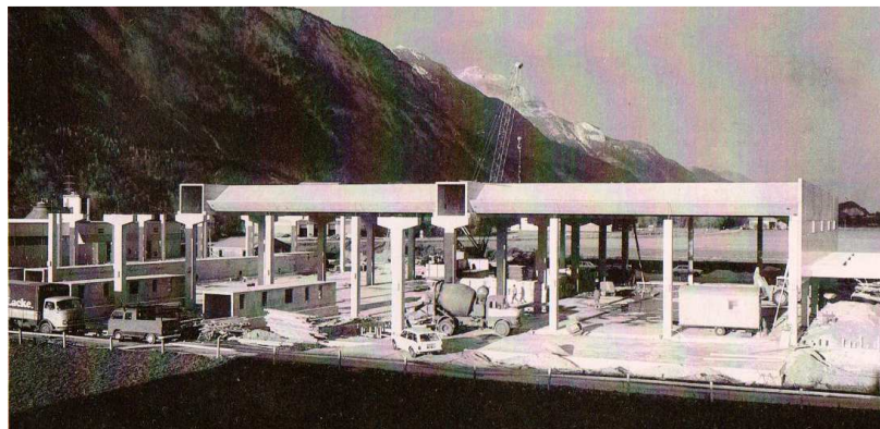
Neubau der Produktionshallen aus Fertigteilen
