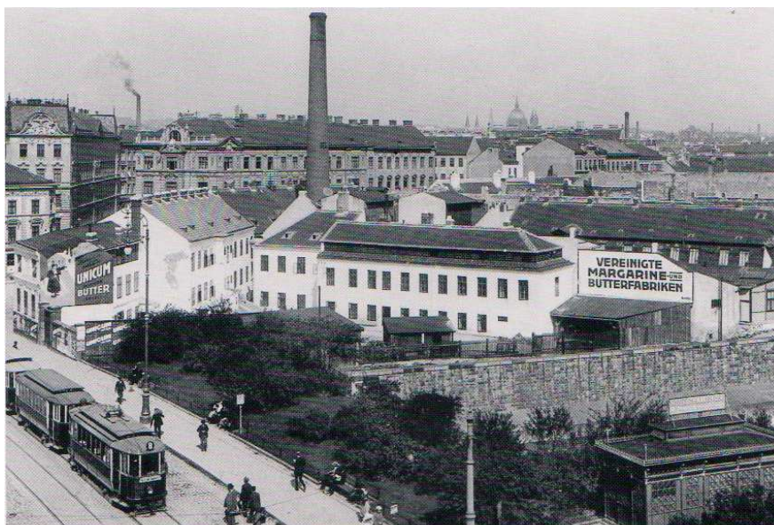
69 Blick über die Lobkowitzbrücke in die Diefenbachgasse.
