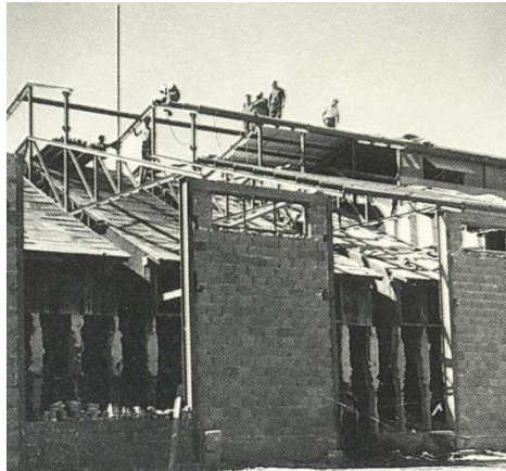
Neubau der Produktionshalle 1962
