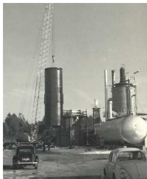
Neubau Oxidationsanlage II 1977
